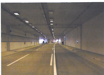
Bild 22: Gesamtansicht des sanierten und nachgerüsteten Tunnels Flughafen Tegel
