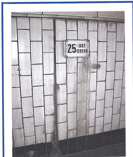
Bild 1: Schadhafte Wandfuge
