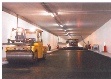
Bild 17: Einbau der Deckschicht
