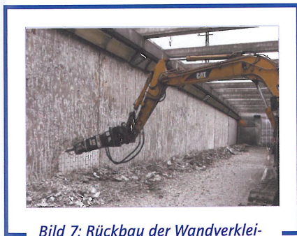
Bild 7: Rückbau der Wandverkleidung im Trogbereich
