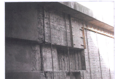
Bild 16: Spritzbetonbereich Übergang Tunnel / Trog – Tunnelbereich fertig gestellt / im Trog vorbereitet zum Spritzbetonauftrag
