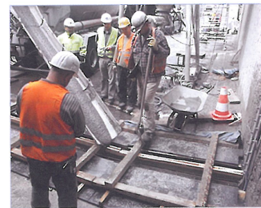
Bild 11: Einbringen des selbstverdichtenden Betons in der Sohlfuge
