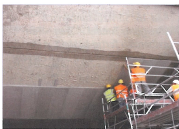
Bild 18: Montage der Brandschutzdecke im Bereich Tunnelportal
