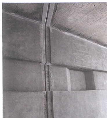
Bild 14: Fugenverlauf im Bereich der Kabelnischen
