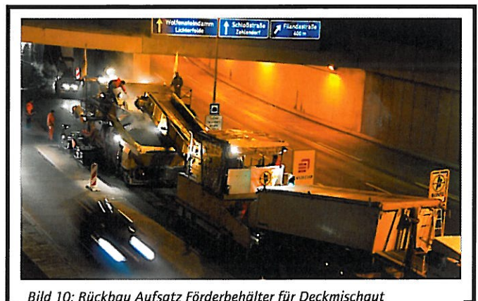
Bild 10: Rückbau Aufsatz Förderbehälter für Deckmischgut
