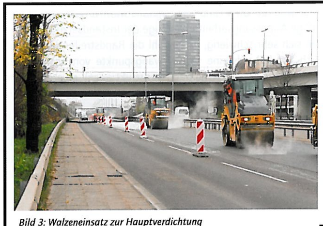
Bild 3: Walzeneinsatz zur Hauptverdichtung
