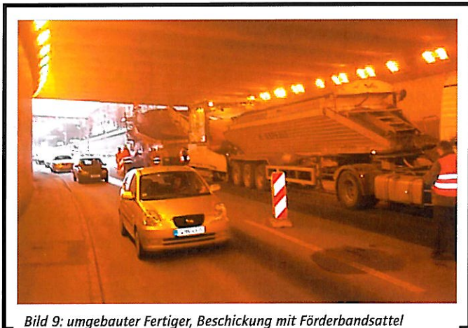
Bild 9: umgebauter Fertiger, Beschickung mit Förderbandsattel
