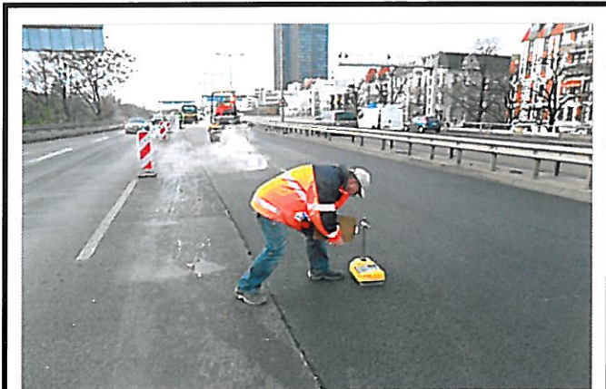
Bild 4: Verdichtungsmessung mittels Isotopsonde
