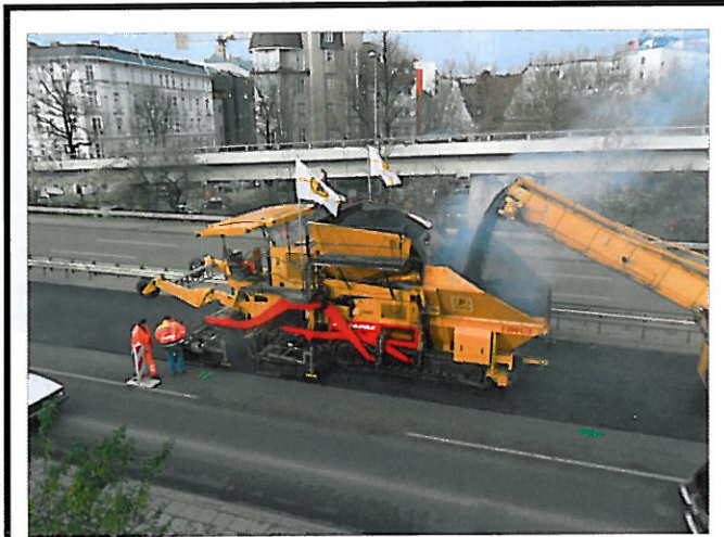
Bild 2: Fertiger (Beladung Binderschicht)
