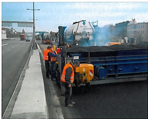
Bild 7 und 8: Einbau Gußasphalt auf Ingenieurbauwerk mit Einbaubohe und Abstreuerung
